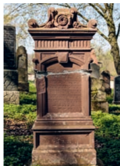
Bei der Schändung des Friedhofs Schopfloch 1938 quer gebrochener Grabstein, nach 1945 unsachgemäß wiederhergestellt (Foto: Günter Schmidt)
