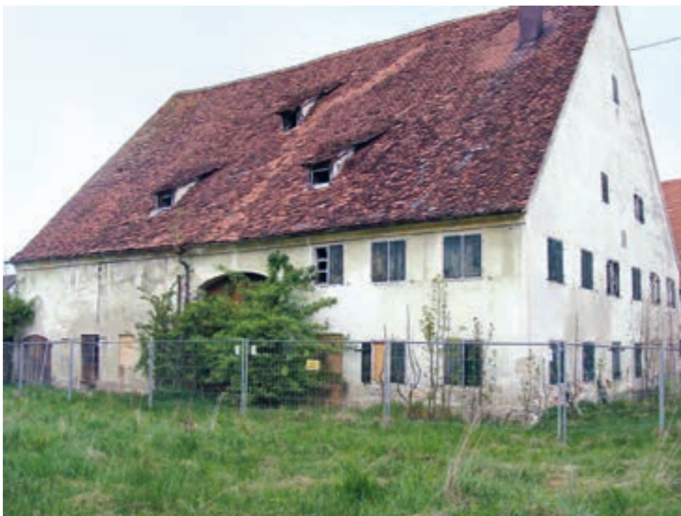
Der Zehntstadel vor Instandsetzungsbeginn, Ansicht von Südosten (Foto: Johannes Wiest, Steinheim)
