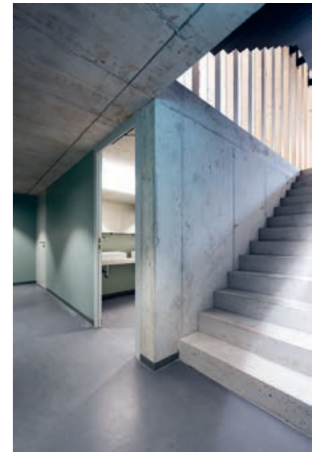
Die notwendigen WC-Anlagen fanden in einem neu geschaffenen Keller unter dem Saal Platz.
