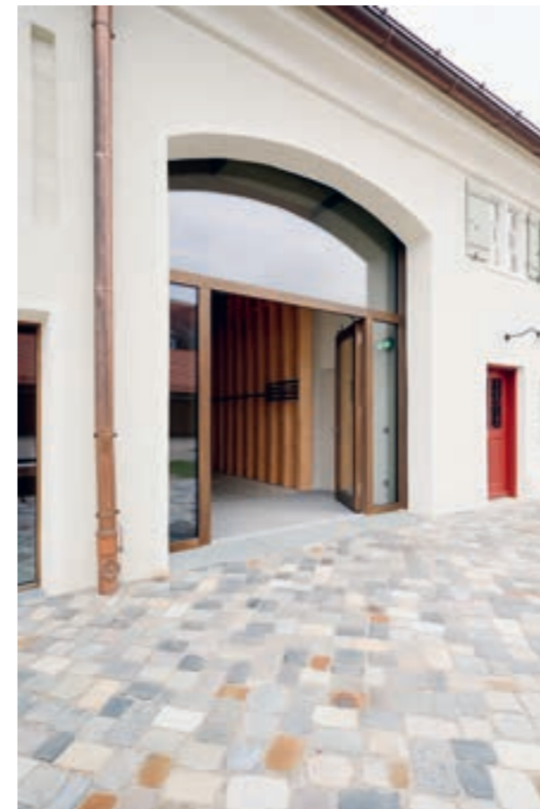
Der Zugang zu Foyer, Saal und Dachgeschoss erfolgt über das nun verglaste südliche Tennentor.
