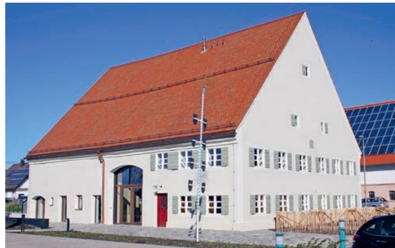
Der Zehntstadel nach der Instandsetzung, Ansicht von Südosten (Foto: BLfD, Michael Habres)
