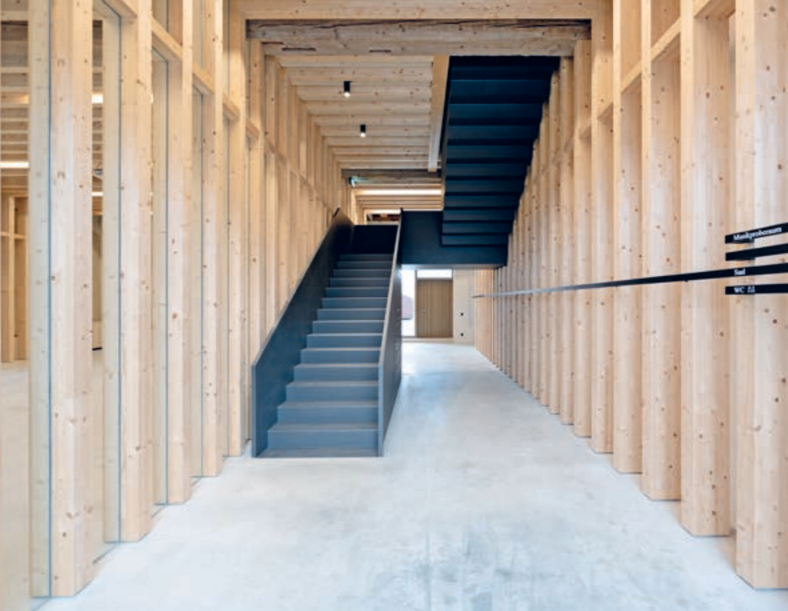
Foyer im Bereich der ehemaligen Tenne. Die modernen, eingestellten Holzkonstruktionen dienen nicht nur der räumlichen Abtrennung, sondern erfüllen auch statische Funktionen. (Foto: Elena Henrich)
