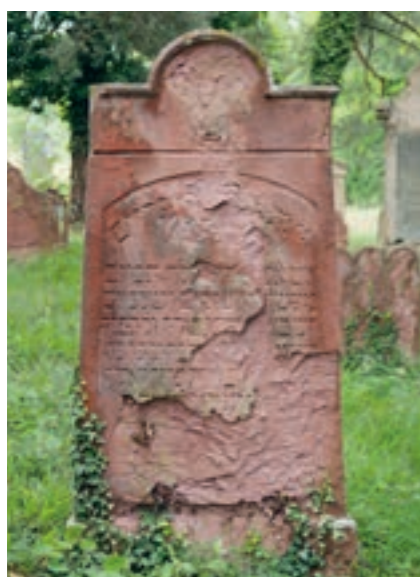
Grabmal aus Buntsandstein, Schalenbildung, Verluste im Schriftbereich, Sockelschäden, Auflagen von Flechten und Algen (Foto: BLfD, Christoph Sabatzki)
